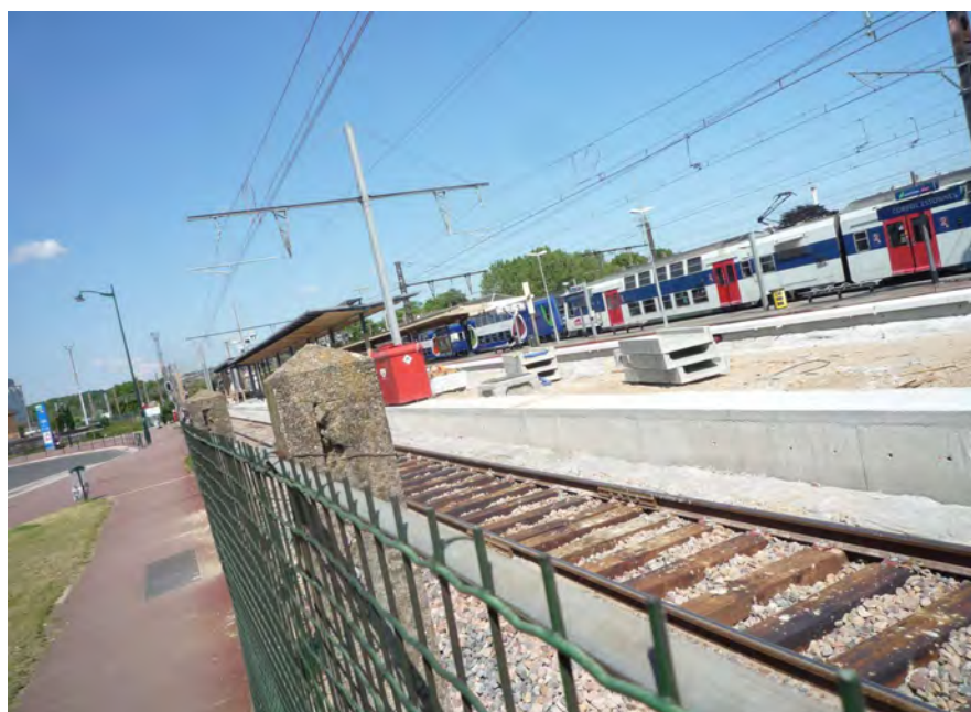
Photo 7 : Le quatrième quai et la voie supplémentaire de la ligne D en construction – Source : Egis Environnement 6 juin 2013
