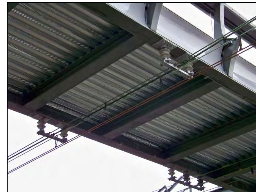
Figure 72 : Exemple d'équipement surélevé en sous face de tablier d'une passerelle piétonne – Source : études AVP Egis
